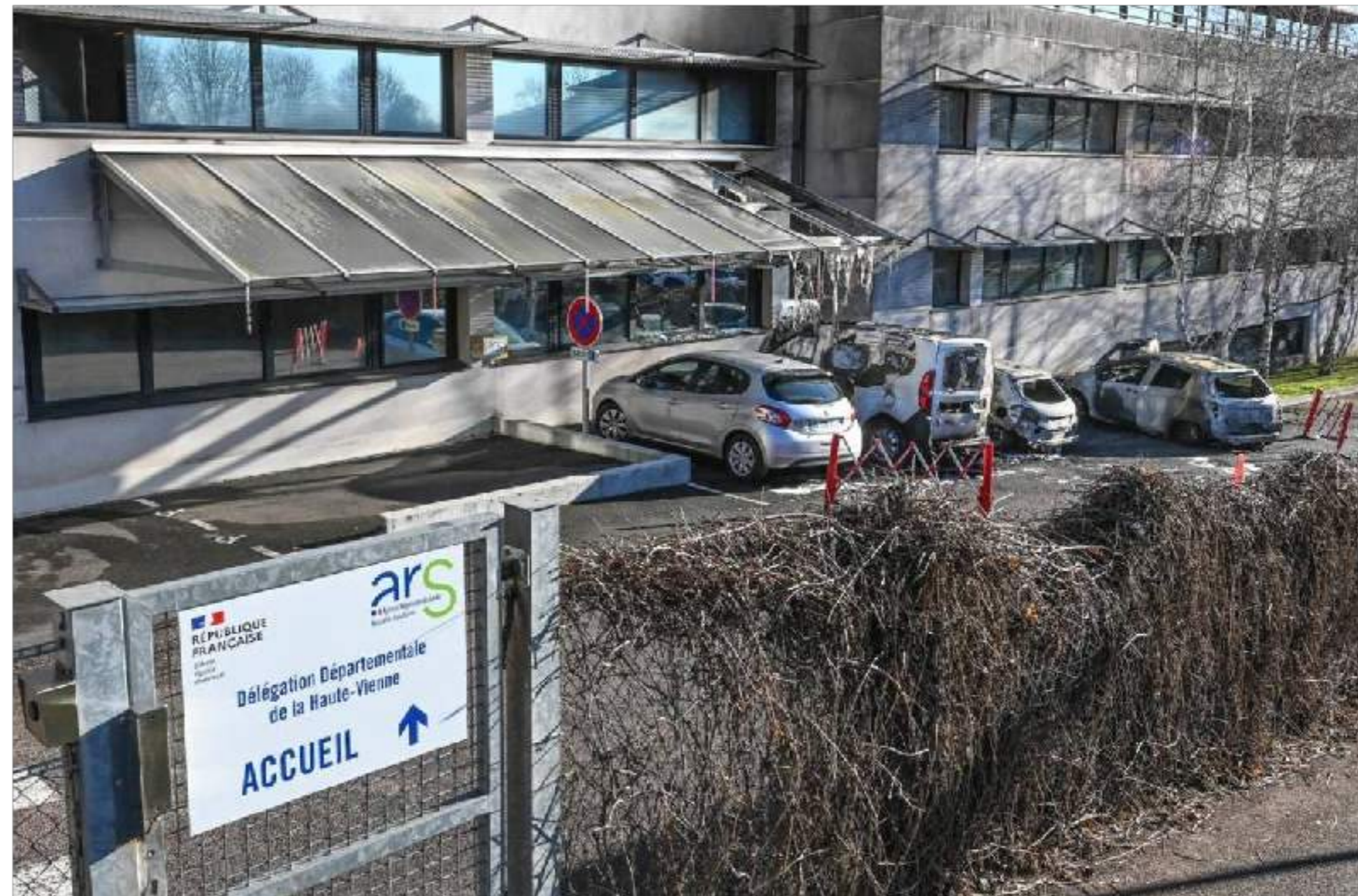
Parking et bureaux de l'ARS de Limoges suite à l'incendie de janvier 2022.
